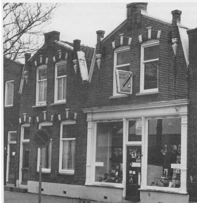
Achter dit winkelpand aan de Kanaalstraat in Oost-Souburg, de huidige boekhandel Huson, lag de drukkerij van Jacques de Smit, waar onder meer Trouw werd gedrukt. De foto is na de oorlog gemaakt.
